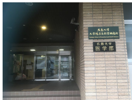
医学部基礎医学研究棟
